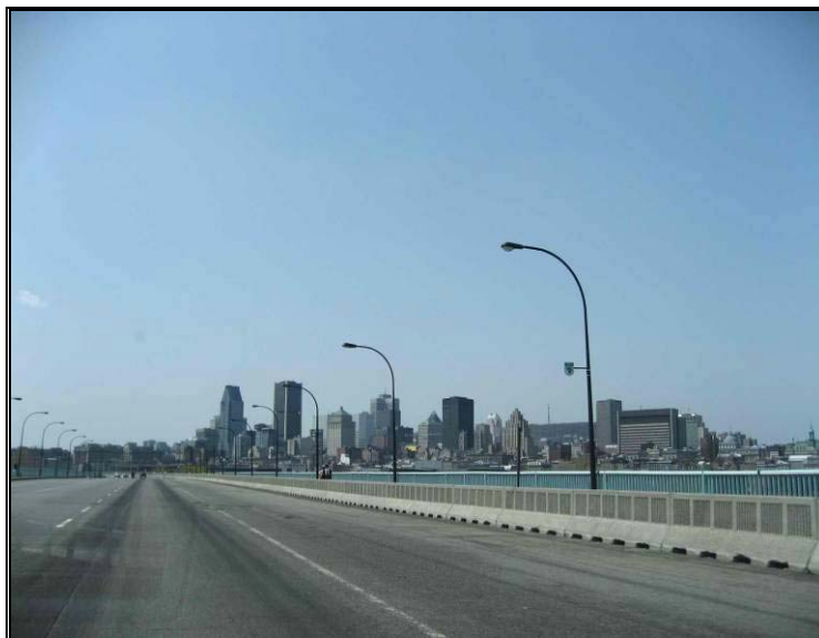
Fig. 26- A photo of Pont de la Concorde
