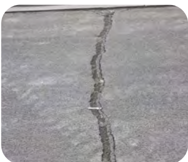
Longitudinal Cracking
